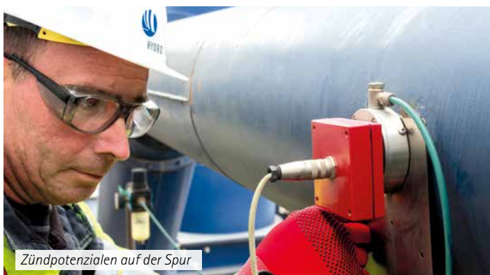
Direkt in der Absaugleitung: hochsensible Funkenmelder
