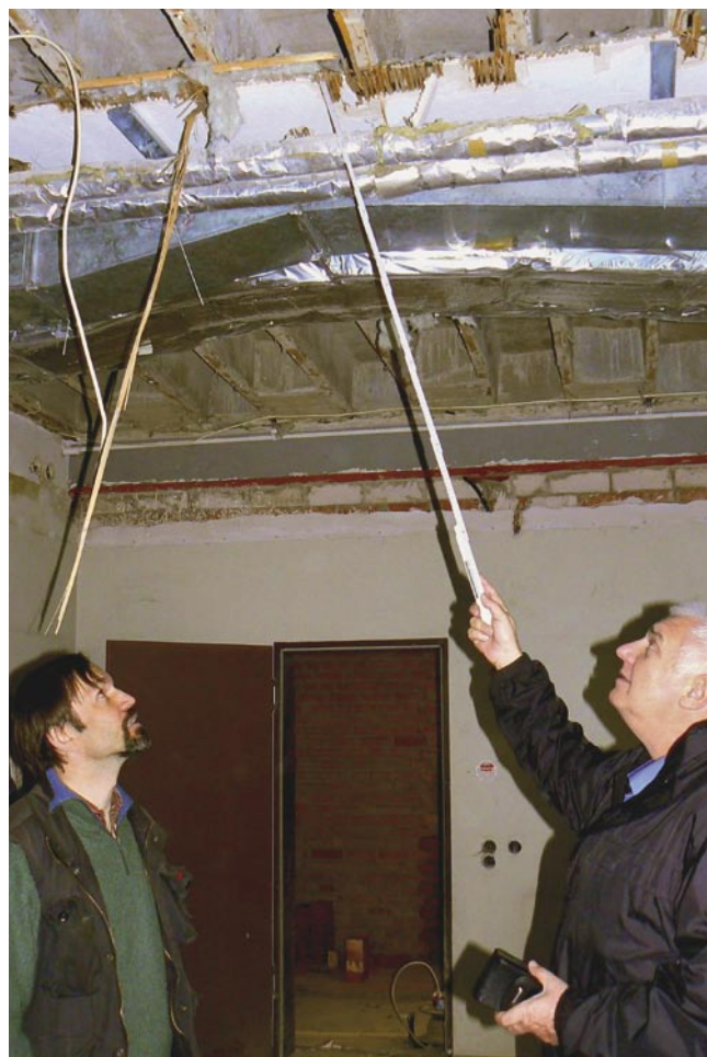
Zusammen mit Klaus Ziegler vom Ingenieurbüro Sattes (links) begutachtet Ernst Plannasch die mit Schilfmatten verkleideten Decken – Brandlasten, die nun rückgebaut werden.
