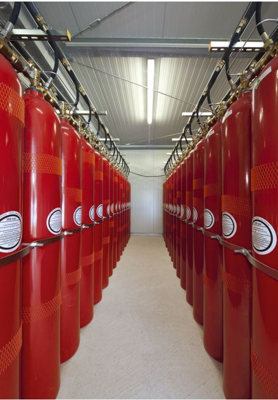
Moderne Gaslöschanlagen werden mit natürlichen und somit ökologisch unbedenklichen Gasen wie Argon, Stickstoff oder Kohlendioxid ausgestattet.
