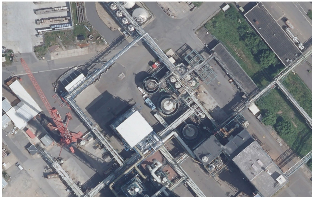
Ein Blick auf das Recycling- und Entsorgungszentrum des Chemeparks Leverkusen mit der Sondermüllverbrennungsanlage
