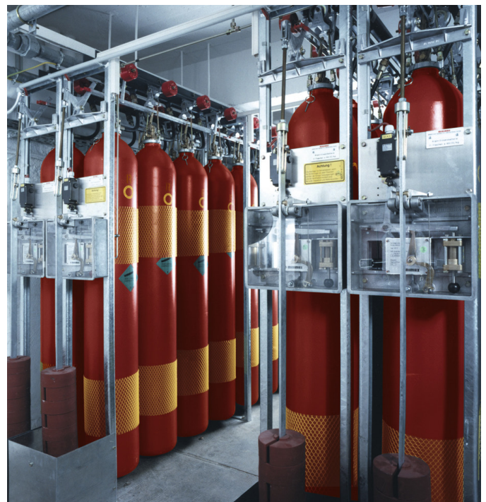
Gaslöschanlage
