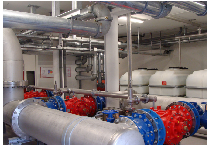
Schaumlöschanlage
