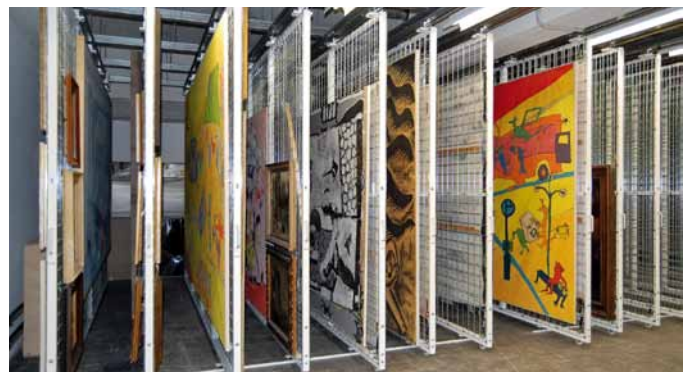
Brandschutz in 5 m Tiefe gibt es im museum kunstpalaest (Düsseldorf) durch eine Spezial-Löschanlage mit platzsparender Löschmittelbevorratung.
